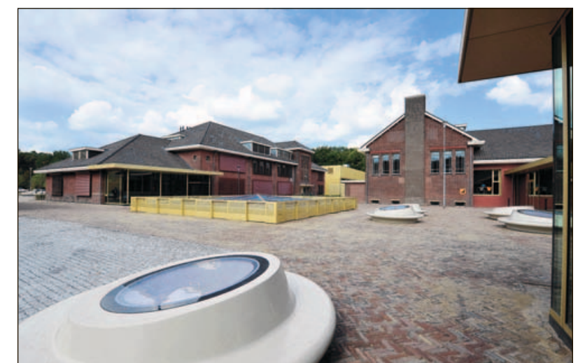
Lichtkoepels voor ondergrondse ruimten op de vroegere appèlplaats.
